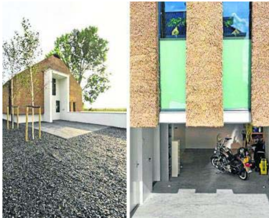
Casa de paja en Zoermeer, Holanda. Arquitecto: Arjen Reas.
